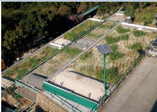
新落成的人工濕地廢水處理系統種植了水生植物。
