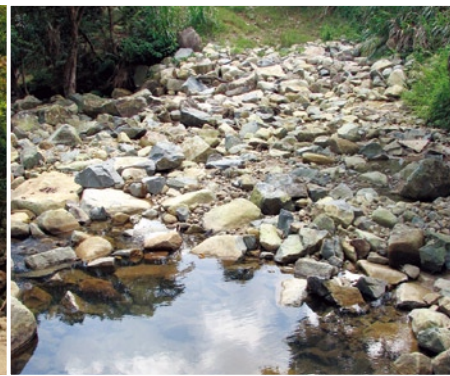
右：大埔地政處接獲本園及其他非政府組織建議後進行拆橋及修復工程。
