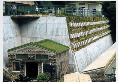
雞棚背後的斜坡鞏固工程。
