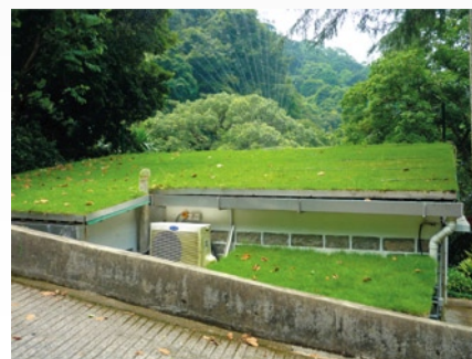
昆蟲館綠化屋頂。
