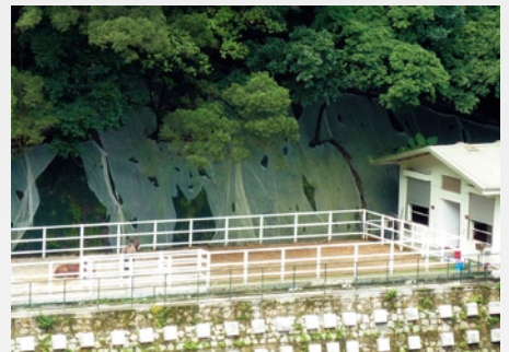
驃房背後的斜坡鞏固工程。
