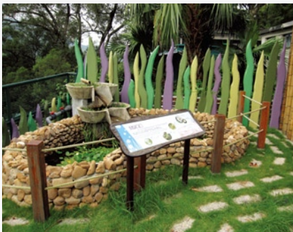
人工濕地污水處理系統的新池塘。
