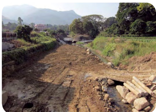
林村河河道工程 — 這些人工建構令香港生機勃勃的天然河溪系統變成不毛的混凝土水槽。
