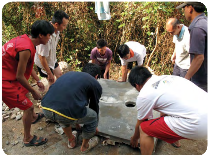
俄賢嶺石灰岩森林的護林員正建造該社區第一個堆肥旱廁所。
