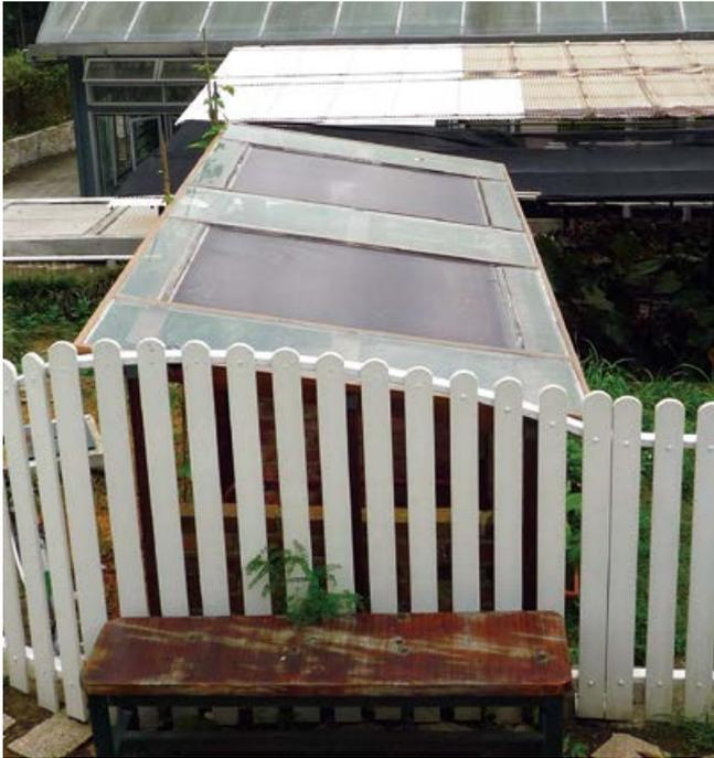
設於「一斗田」農圃上的「光伏系統之電力裝置」(BIPV)正在運作中。
