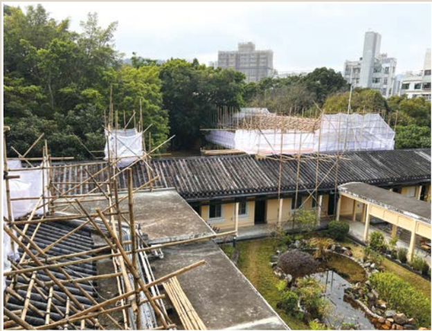
綠匯學苑的古蹟維護工程，充份考慮按鷺鳥繁殖季節所需而制定施工安排
