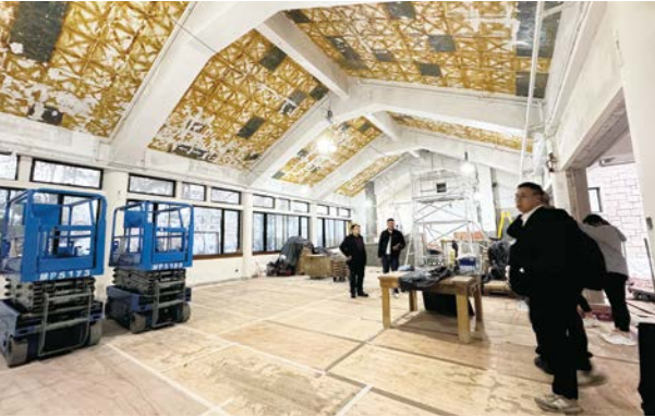
Food Hub的翻新工程進行中
