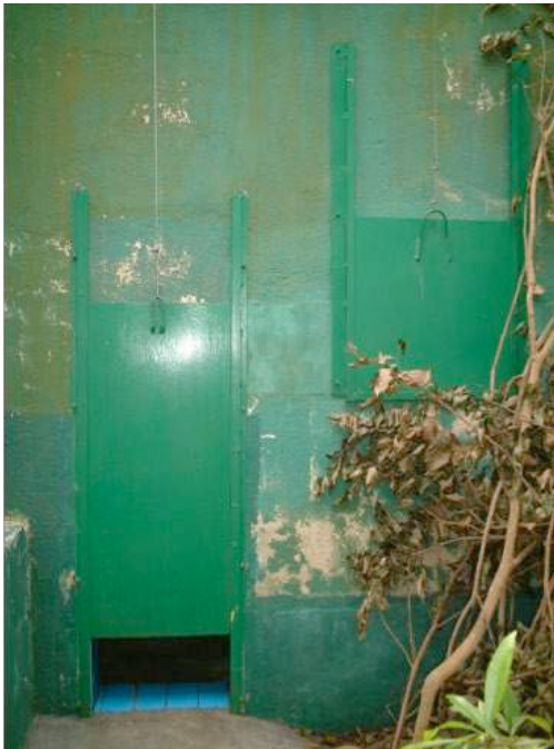
圖 33 可在籠外控制的安全滑門設計
